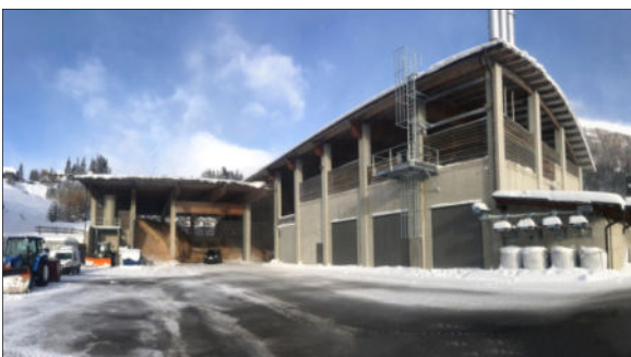
Biomasseheizwerk Katschberg (Quelle: RPK ZT-GmbH)
