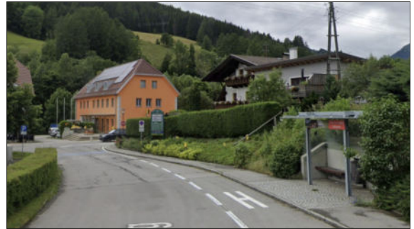
Bild 2: Östliche Ortseinfahrt mit Gemeindeamt (Google Maps)
