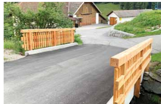
Ebenfalls neu errichtet wurde die zweite Brücke in der Ortschaft Abwerz.
