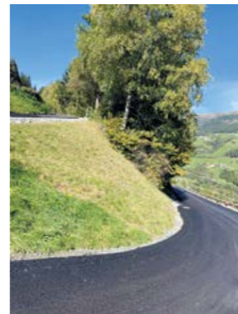
Die sanierte Straße nach Oberschlaipf
