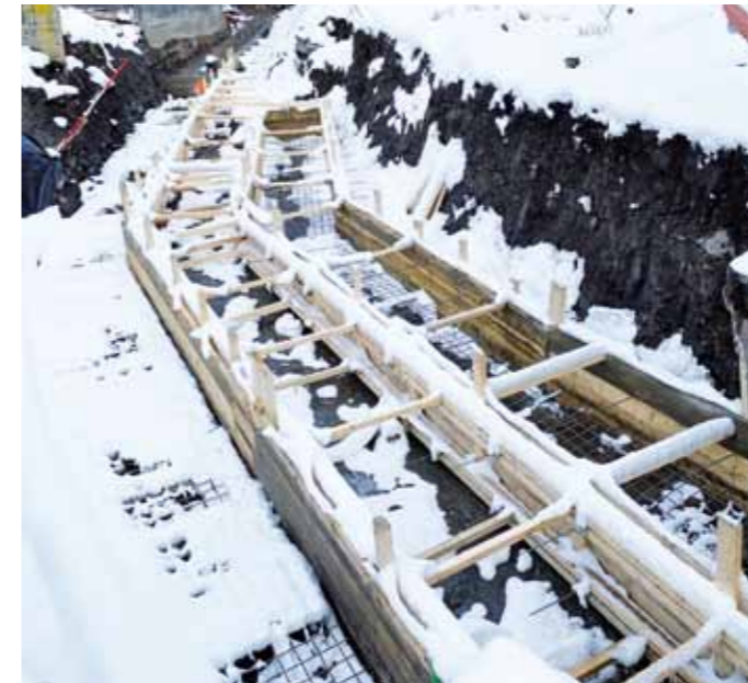
Beginn der Bauarbeiten Anfang März
